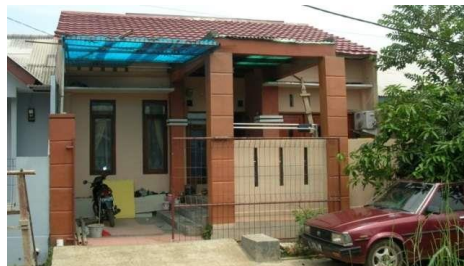
Gambar 3. Foto Eksisting Rumah dengan Atap Metal Sheet Tanpa Insulasi
