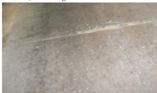
Gambar 12. Rusaknya perkerasan beton pada sambungan akibat *blow-up*
