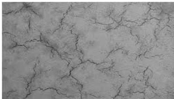
Gambar 3. Retak sambung (*Joint Reflex Cracking*)
