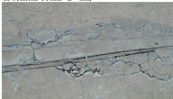
Gambar 11. Retak daya tahan (*Durability "D" Cracking*)
