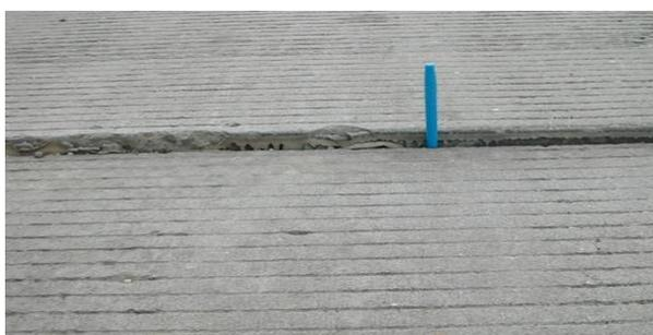
Gambar 9. Penurunan atau patahan (*Settlement or Faulting*)
