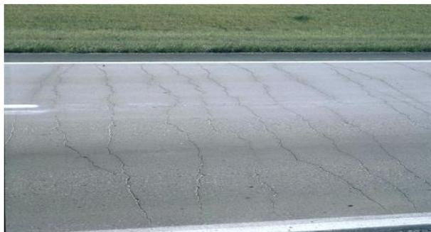
Gambar 5. Retak memanjang / melintang (*Longitudinal / Trasverse Cracking*)
