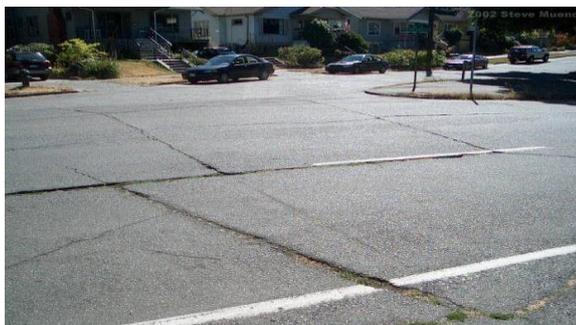
Gambar 8. Retak slip (*Slippage Cracking*)
