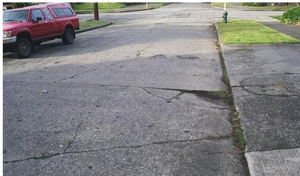
Gambar 2. Retak samping jalan (*Edge cracking*)
