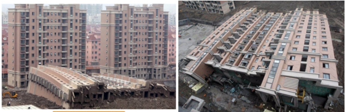
Gambar 3. Kegagalan konstruksi bangunan
