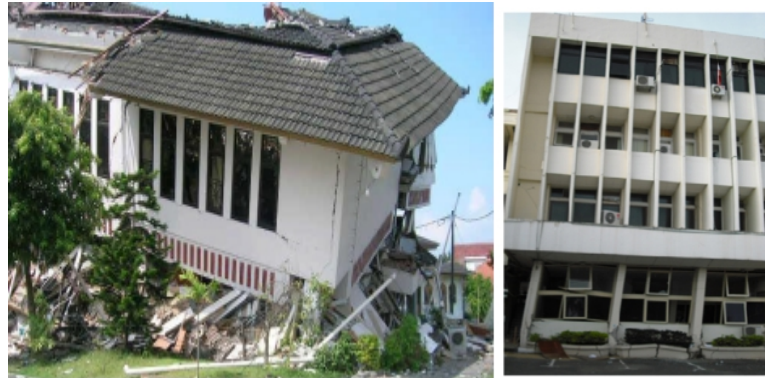
Gambar 5. Kegagalan pondasi akibat efek liquifaksi (Zaidir, 2018)
