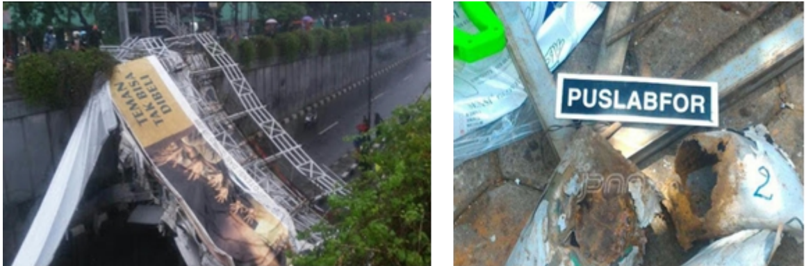
Gambar 3. Kondisi Jembatan penyebrangan orang (JPO)
