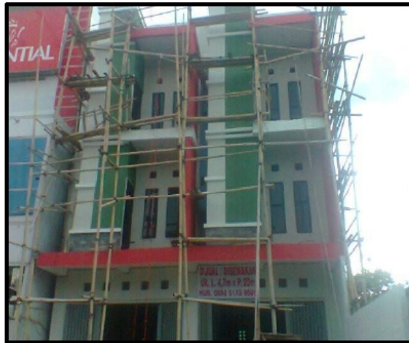
a. Kondisi existing bangunan ruko lantai tiga
