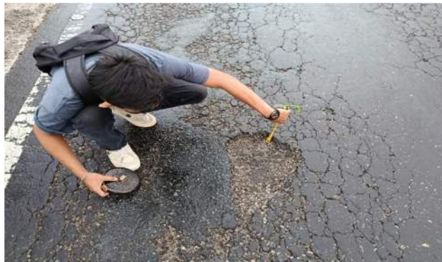
Gambar 1. Kerusakan Berupa Lubang
