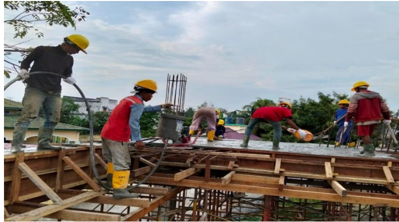
Gambar 1 Penggunaan Alat Pelindung Diri (APD) oleh pekerja di lokasi proyek
