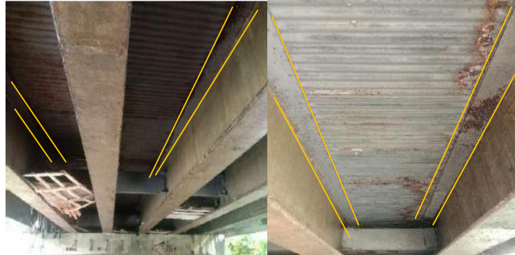
Gambar 7. kerusakan pada gelagar (Sumber: dokumentasi)
