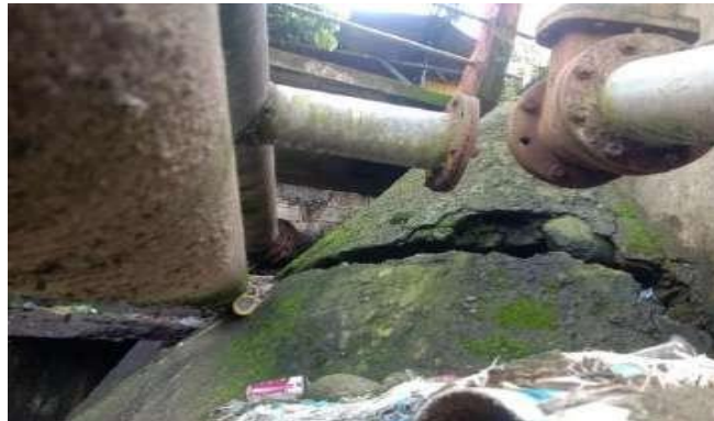
gambar 9. kerusakan dinding sayap (Sumber: dokumentasi)
