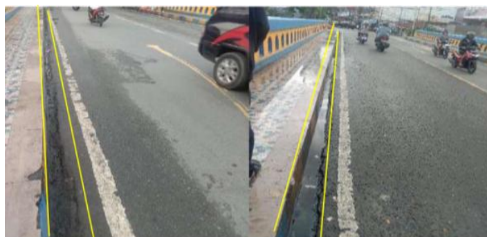
Gambar 9. pipa cucuran tidak berfungsi (sumber : dokumentasi)
