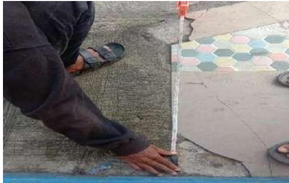
Gambar 5. kerusakan pada trotoar (sumber : Dokumentasi )
