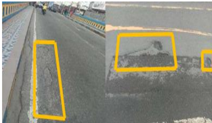
Gambar 4. kerusakan pada lapisan aus (Sumber: dokumentasi)
