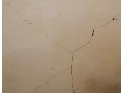
Gambar 4. Retak Pada Dinding
