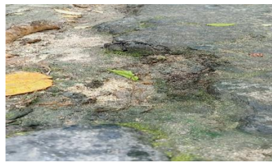
Gambar 9. Cacat Tepi Perkerasan
