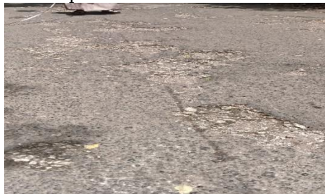
Gambar 7. Pelepasan Butir
