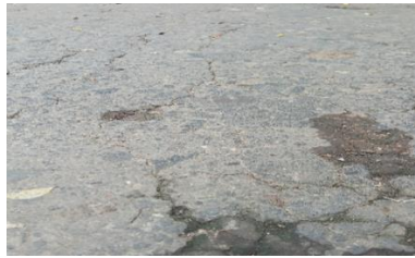
Gambar 3. Retak Melintang
